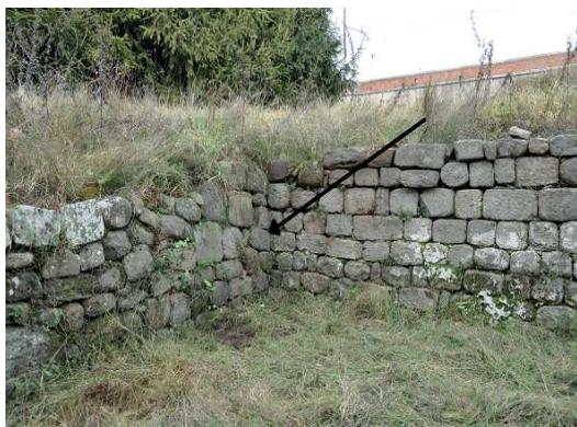
Fig. 18 a e 18b. Muratura superstite della chiesa di Sant'Allucio di Pescia. La linea bianca e la freccia separano la porzione originale del muro a secco di realizzazione postbellica.
