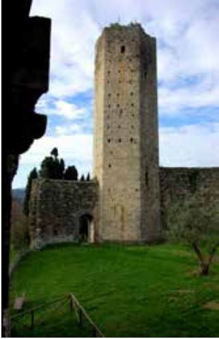
Fig. 6. Torre esagonale, Serravalle Pistoiese.
