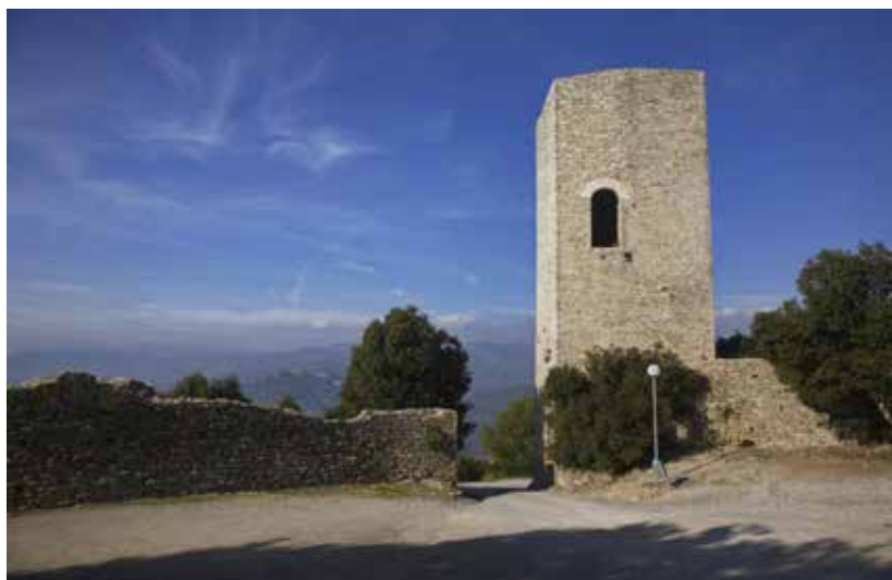
Fig. 10. La torre restaurata, Monsummano (Alto).
